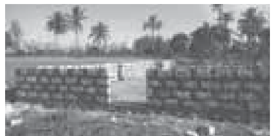
De bouw voor de slaapzaal voor de jongens is gestart.
